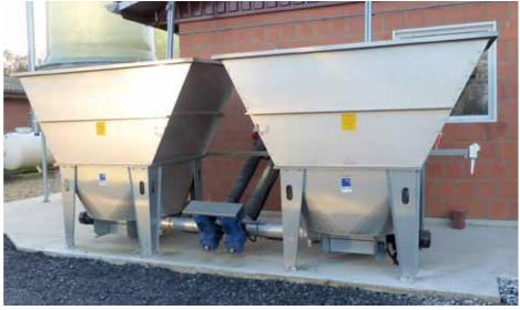
2Stück UNI-Dos Typ45 in Edelstahlausführung mit  $3,2~{\rm m}^3$  Lagervolumen, Entnahmeschnecke Typ160, Abdeckung aus Edelstahl mit Handkurbel
