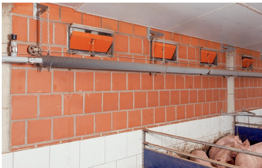
Ogrzewanie żeberkowe wykonane z aluminium jako ogrzewanie pomieszczeń – idealne do stosowania w połączeniu z wlotami powietrza CL 1200
