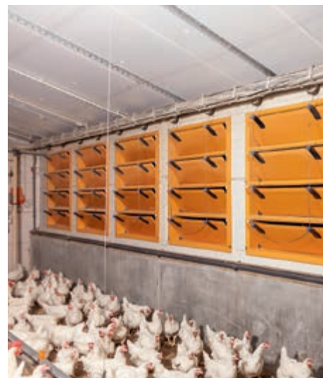
MultiVent 4 – inlet s višestrukim klapnama izrađen od PU
