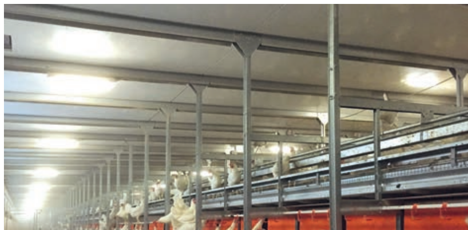
Glatka, bijela površina plastičnih ploča omogućava svježem zraku da neometano protječe unakrsno kroz objekt i povećava razinu svjetlosti na nižoj razini
