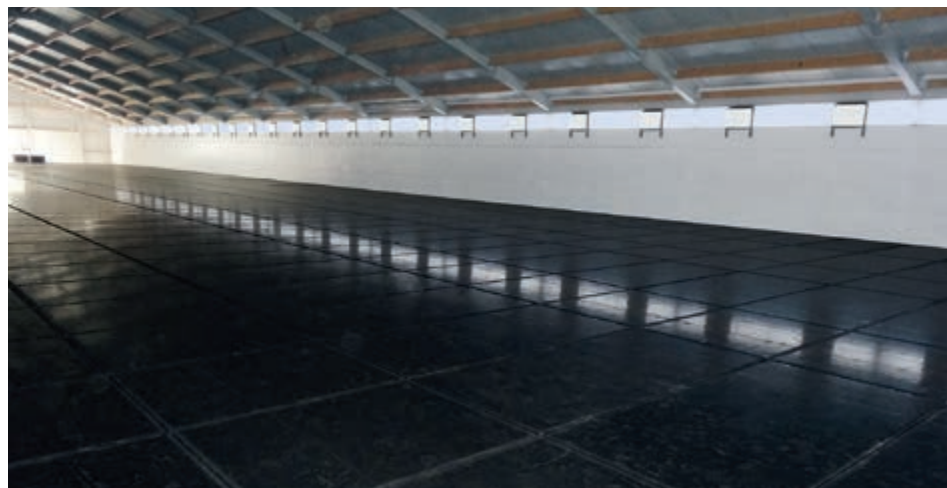
Pogled na središnji strop od plastičnih ploča prije ugradnje sustava na drugoj razini
