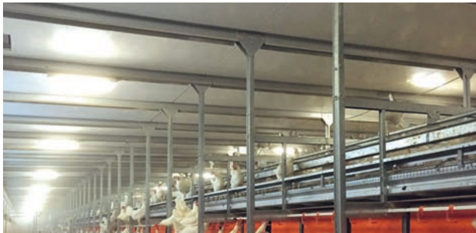
Białe i gładkie spód płyt z tworzywa sztucznego umożliwia bezproblemowy przepływ świeżego powietrza w kierunku poprzecznym w kurniku i dodatkowo zapewnia większą jasność na niższym poziomie
