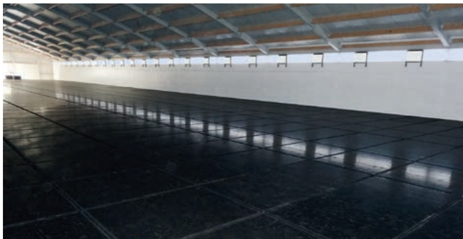
Widok sufitu pośredniego wykonanego z płyt z tworzywa sztucznego przed montażem systemu na drugim poziomie
