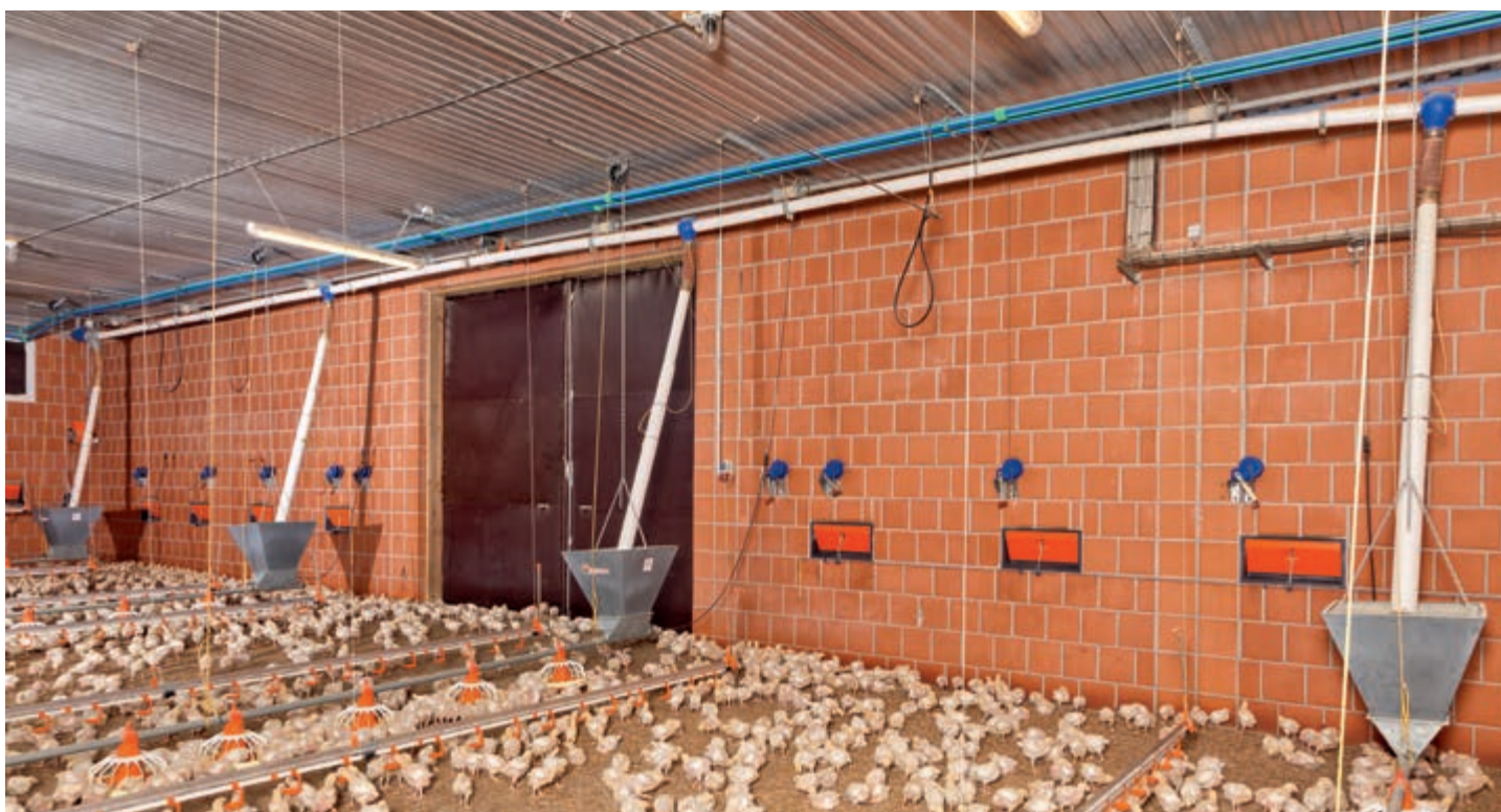
Upotreba vitla za sajlu za podešavanje optimalne visine linija napajanja u skladu sa starošću peradi
