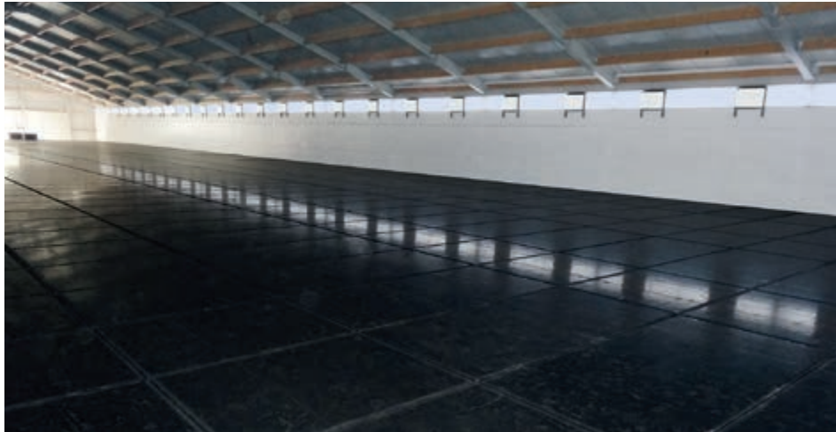
시스템이 2층에 설치되기전에 플라스틱보드로 만들어진 중간천장의 모습
