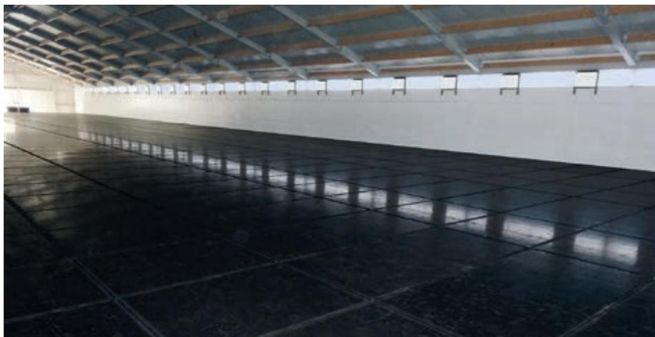
Immagine di un solaio intermedio costituito da pannelli di plastica prima che il sistema sia installato al secondo piano
