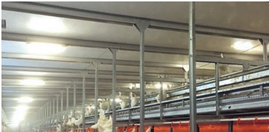
Гладка біла поверхня пластикових панелей дозволяє свіжому повітрю вільно та без перешкод рухатись по будівлі. Також вони збільшують рівень освітлення на нижньому ярусі
