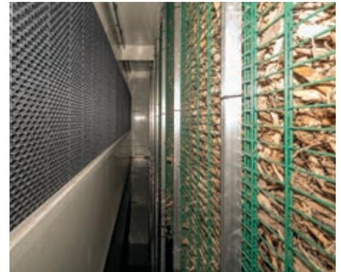
Blick in die zweite Druckkammer: Links befindet sich der Tropfenabscheider, rechts die Biofilterwand
