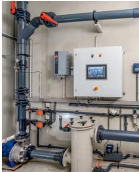
Werksseitig vorinstallierter Technikraum mit Steuerung
