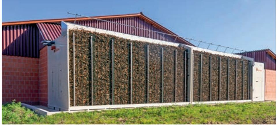
PURO verfügt über zwei Reinigungsstufen. Die erste Stufe besteht aus einer Kunststoff-Filterwand, die kontinuierlich von oben mit Wasser berieselt wird. Unter Zugabe von nur wenig Schwefelsäure entsteht bei der biologischen Variante ein schwach saures
