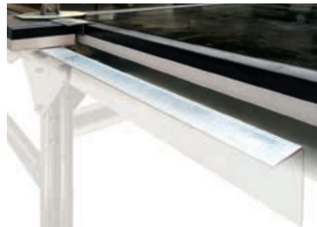
A tartószerkezet körüli, zárt műanyag lapok felül sötét, míg alul világos felülettel.
