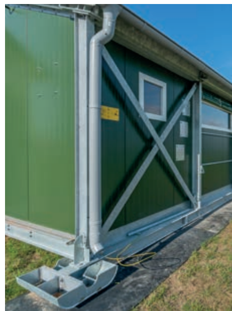
Използване на шейна за промяна на местоположението
