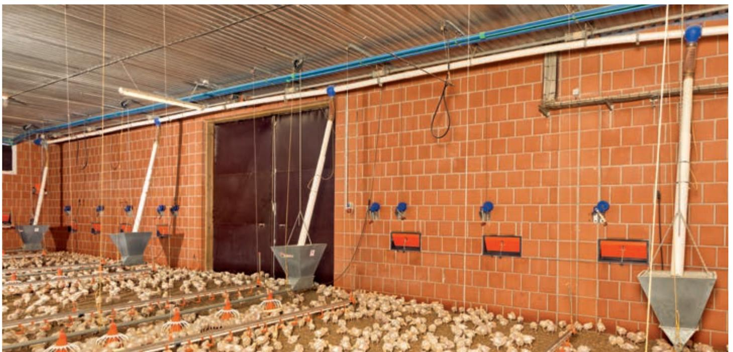
Utilisation des treuils à câble entre autres pour régler de façon optimale la hauteur des rangées d'abreuvoirs selon l'âge des animaux
