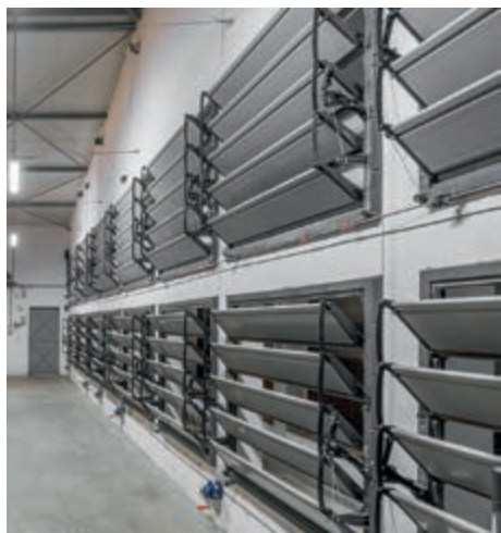
MultiVent 17 M во фронтовой стене, для туннельной вентиляции
