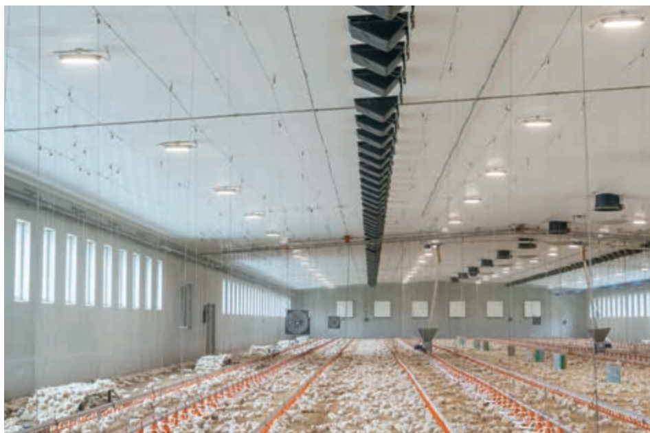
Монтаж потолочного клапана CL 1540 в промежуточное перекрытие бройлерного корпуса
