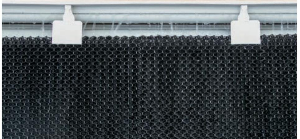
Top-Profil mit gelochtem Rohr und Deflektor zur gleichmäßigen Wasserverteilung auf die Pads
