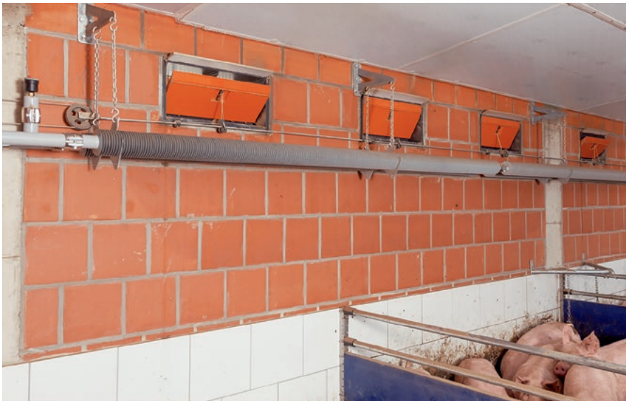
Aluminijski rebrasti grijač kao sistem grijanja za cijeli prostor – idealno u kombinaciji sa inletima za ulaz zraka
