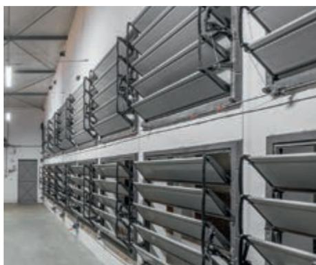
MultiVent 17 M nella parete lato testata per ventilazione a tunnel
