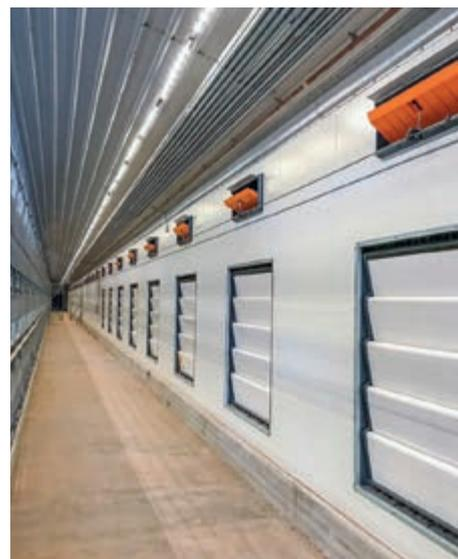
Capannone avicolo con ventilazione CombiTunnel che utilizza prese a parete CL 1911 F e serrande MVT
