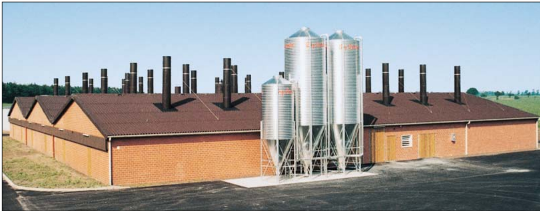
Exaustão descentralizada do ar
