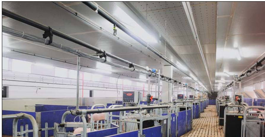
Doprowadzanie powietrza poprzez kanał zraszający w sektorze loch prośnych
