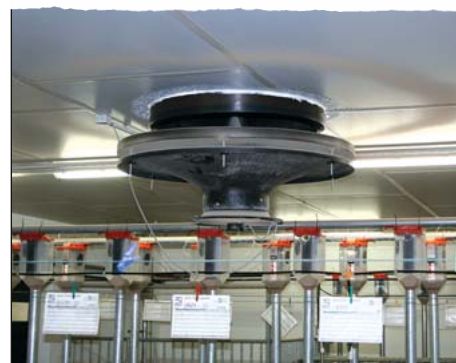
Komin doprowadzający powietrze FAC z siatką ochronną (w opcji) i jednostką recyrkulacyjną
