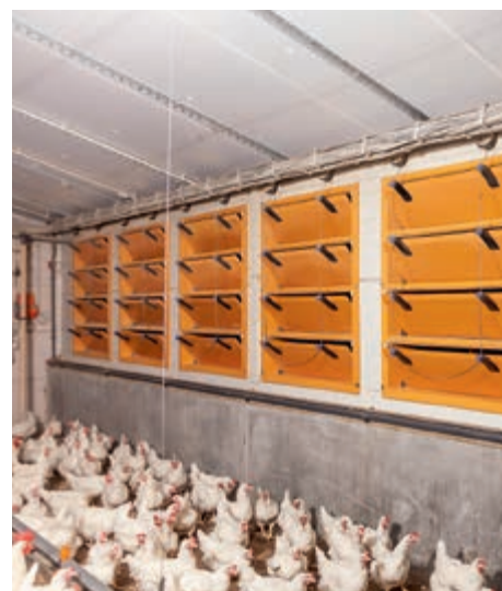
MultiVent 4 – Višenamenski ulaz vazduha napravljen od Poliuretana
