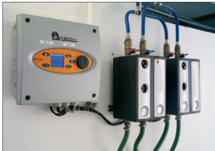
Klimapočítač MC 235 k riadeniu celej maštálnej klímy a trojstupňová regulácia pre vykurovanie vodou
