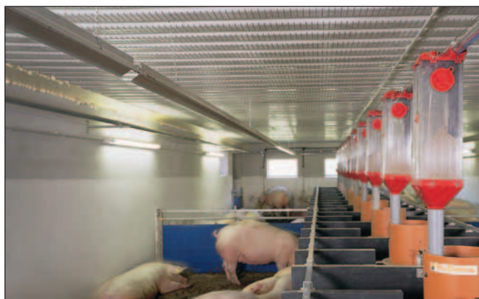
Deltatrubky – ideálne pre montáž pod difúzny strop
