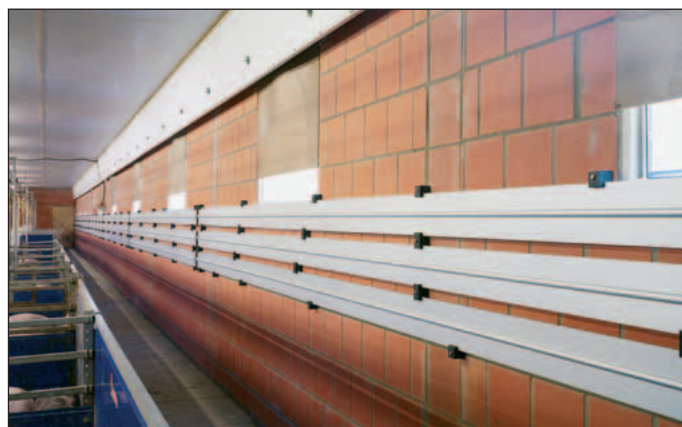
Twinrúry – vhodné pre montáž na stenu – menej usadeného prachu
