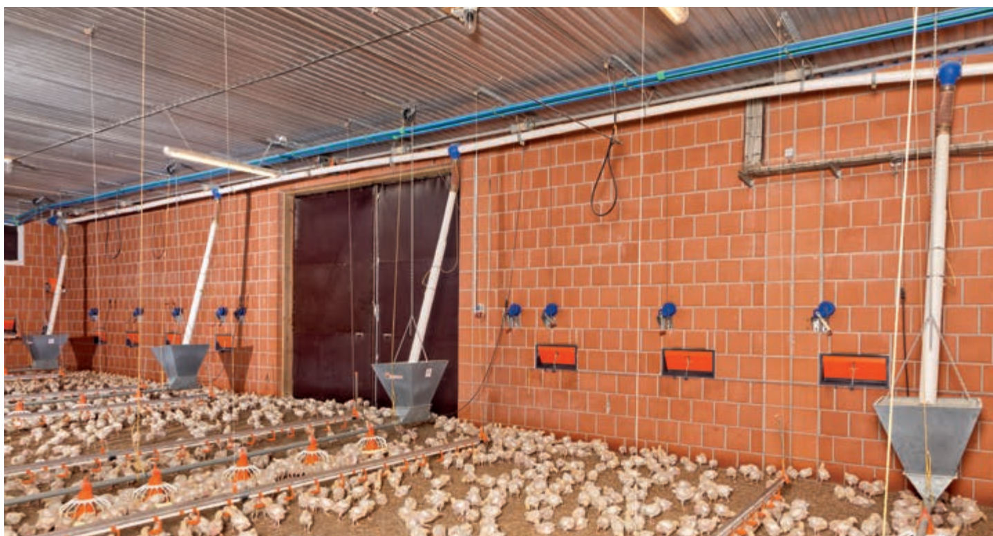
Upotreba vitla za uže za podešavanje optimalne visine linija pojenja u skladu sa starošću živine
