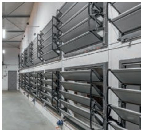
MultiVent 17 M in testata per ventilazione a tunnel
