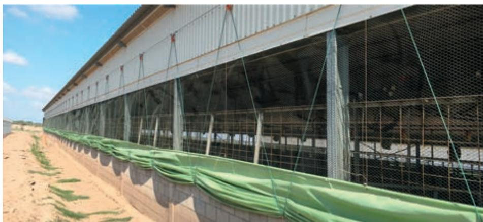
L'uso delle tende a caduta è un metodo semplice ma molto efficace per controllare il naturale scambio d'aria in un capannone. Con il nostro attuatore EWA le tende si aprono e chiudono automaticamente.
