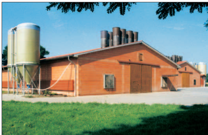
Centralne rozmieszczenie wentylatorów
