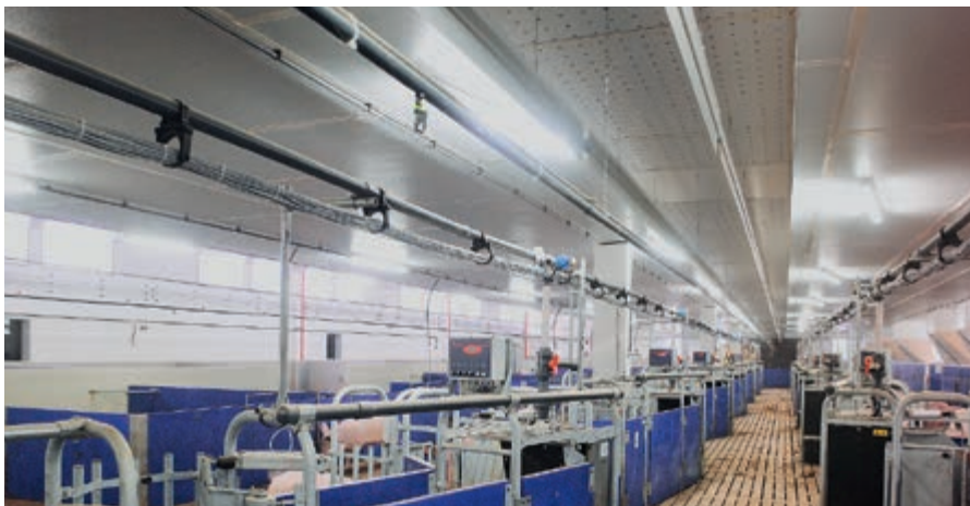
Zrak distribuiran preko perforiranih kanala u suhom objektu za krmače sa ESF sistemom
