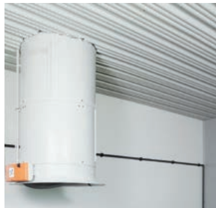
DiffAir spušteni strop u kombinaciji sa CL 600 ventilatorom
