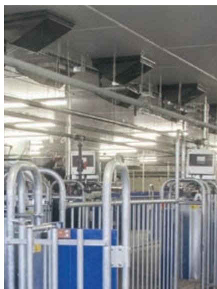
Riscaldatore ad alette come sistema di riscaldamento per l'intero ambiente – ideale in combinazione con le inlet a soffitto
