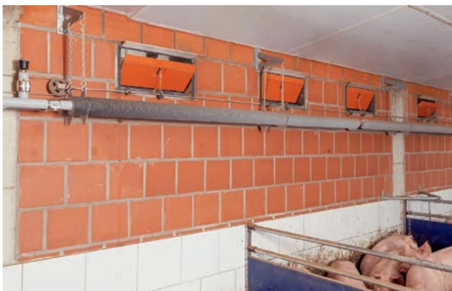
Riscaldatore ad alette in alluminio come sistema di riscaldamento per l'intero ambiente – ideale in combinazione con le inlet
