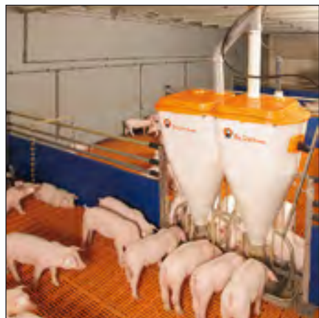
使用 DryExactpro 为保育猪的 PigNic - Jumbo 饲喂器供料
