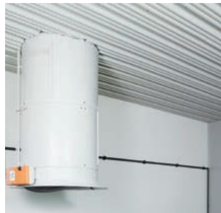
Strop DiffAir v kombinaci s odtahovým komínem CL600
