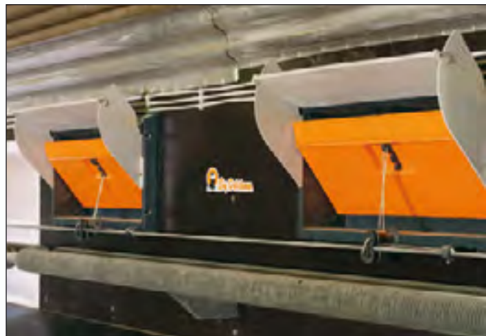
翅片加热管与 CL1200 进风窗的完美组合
