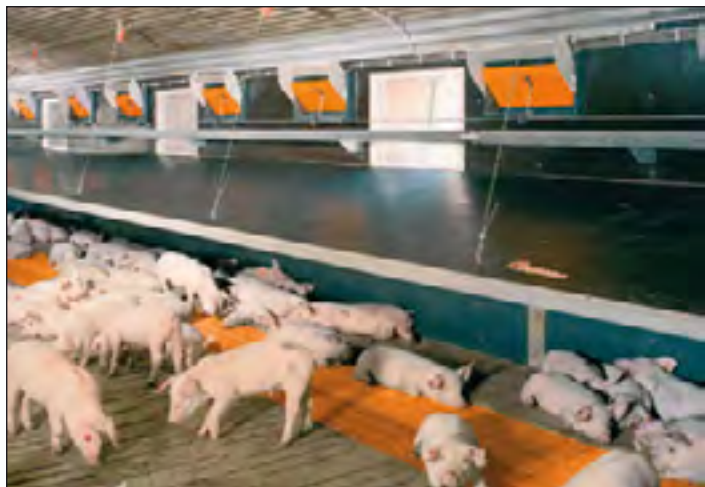
用于保育舍整体加热的翅片加热管系统
