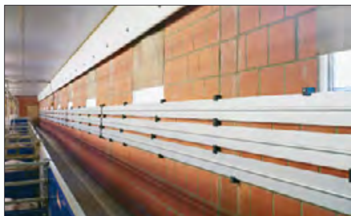
双翼管安装在侧墙上，减少灰尘积累
