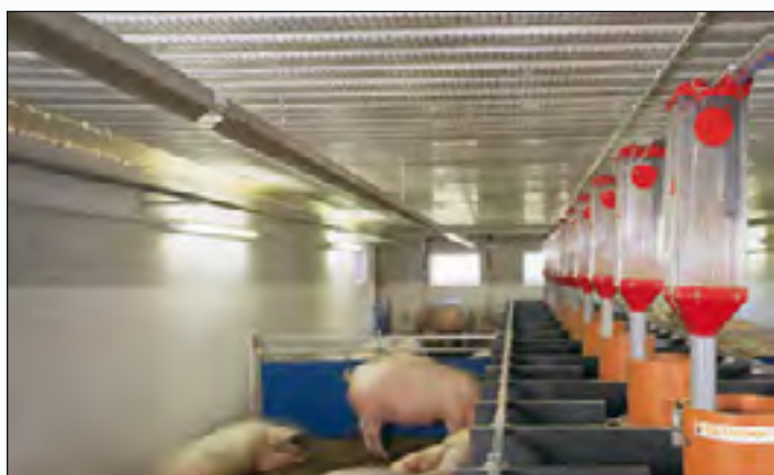
三翼管安装在 Diff-Air 天花板下方
