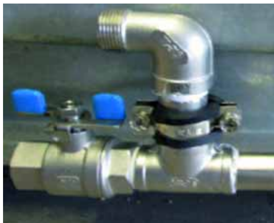
Afbeelding 6-1: Kogelkraan geopend
