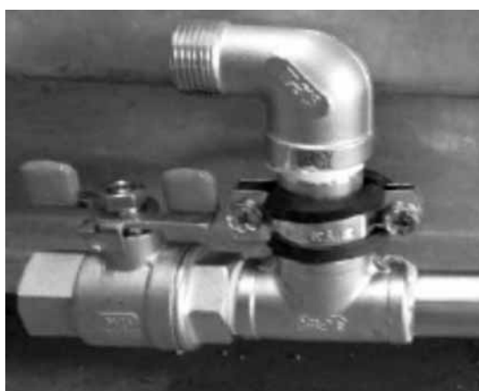
Figure 6-1 : Vanne à bille ouverte
