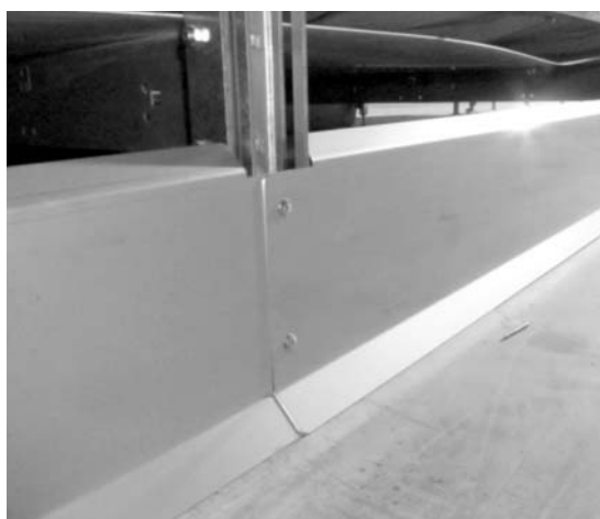
Obrázek 3-9: Posuvný zakončovací plech
