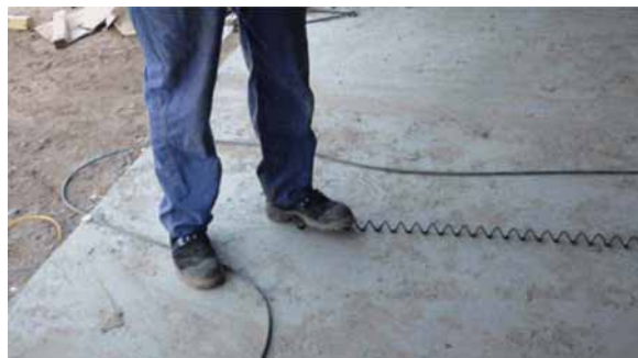
Bild 6-3: Spiralende fixieren
