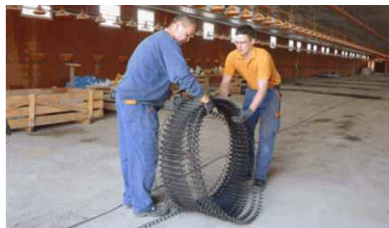
Bild 6-4: Spirale abrollen
