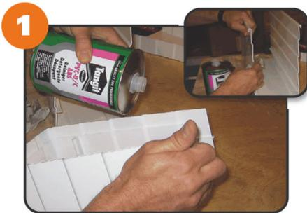
1. Limpe **minuciosamente** todos os pontos de colagem com produto de limpeza Tangit.
