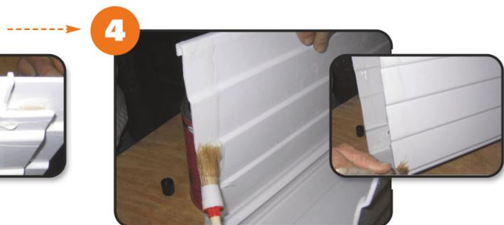
4. Com um pincel, unte **imediatamente** depois, os pontos de colagem na conduta de água **parte interior e exterior** com cola Tangit. Observe o tempo de exposição da cola Tangit (4 min a 20°C).
