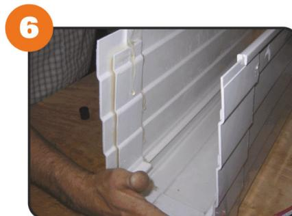
6. Junte **imediatamente** as condutas de água e o acoplamento. Execute esta tarefa **com duas pessoas**.
