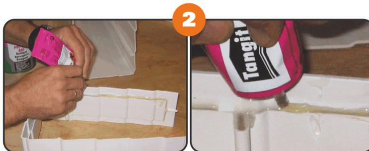
2. Rellene **completamente** la hendidura de la pieza de unión/tapa final con el pegamento Tangit. Utilice para ello el extremo del tubo de pegamento Tangit.
