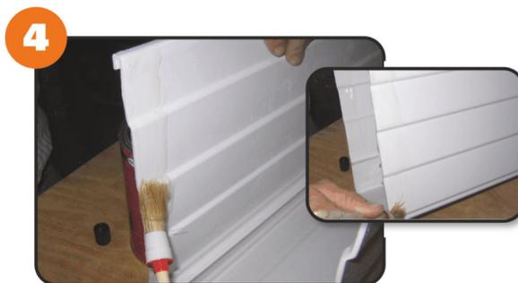
4. Aplique **inmediatamente** después el pegamento Tangit con la pincel en las uniones pegadas de la canaleta de agua **interior y exteriormente**. Tenga en cuenta el tiempo máximo con recipiente abierto del pegamento Tangit (4 min. a 20 °C).
