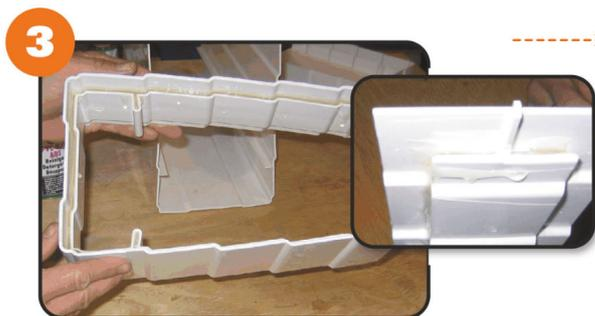
3. Gire la pieza de unión y rellene también **completamente** la hendidura por el otro lado con pegamento Tangit.
