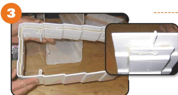
3. Поверните муфту и **полностью** заполните клеем Tangit зазор с другой стороны.
