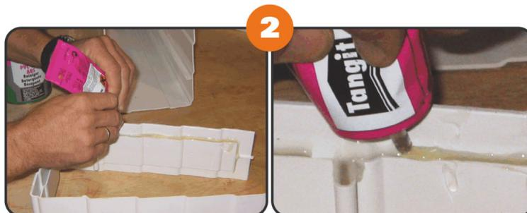
2. **Полностью** заполните зазор в муфте/концевой крышке клеем Tangit. Для этого используйте клей из тюбика с наконечником.
