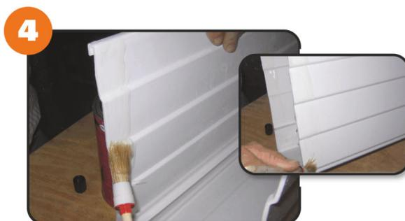
4. После этого **сразу же** смажьте места склеивания на водосточном желобе **внутри и снаружи**, используя кисть с клеем Tangit. Соблюдайте время открытой выдержки клея Tangit (4 минуты при 20 °C).
