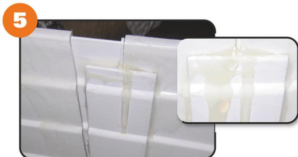
5. Lors de l'assemblage, l'adhésif Tangit doit **s'échapper de la fente**. Si ce n'est pas le cas, cela signifie que la quantité d'adhésif utilisée est trop faible.
