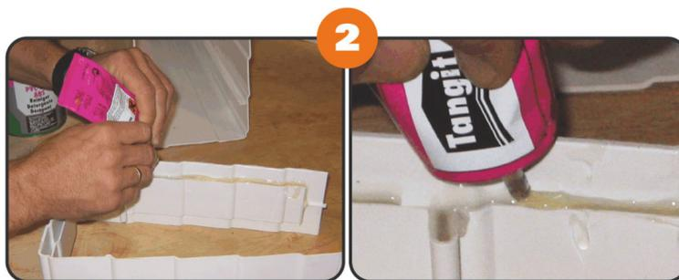
2. Remplissez **complètement** d'adhésif Tangit la fente du raccord/couvercle. Utilisez pour cela la pointe du tube d'adhésif Tangit.
