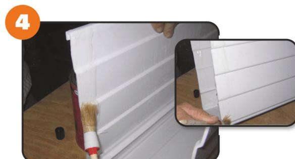
4. Applicare poi **subito** con il pennello la colla Tangit nei punti di attacco sulla canalina dell'acqua **all'interno e all'esterno**. Fare attenzione al tempo di adesione della colla Tangit (4 min a 20 °C).
