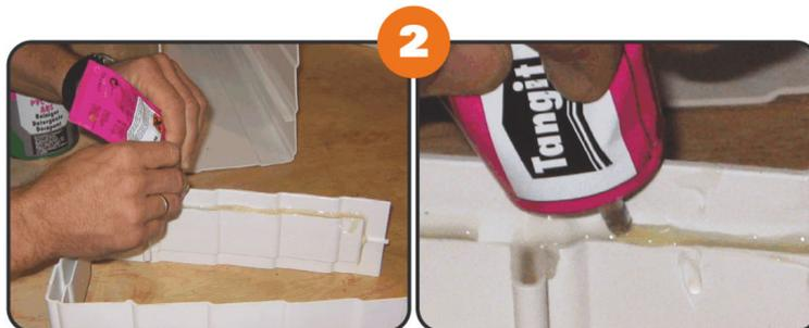
2. Riempire la fessura nel giunto/nella copertura terminale **completamente** con colla Tangit. Utilizzare a tale proposito il tubetto di colla Tangit con la punta.
